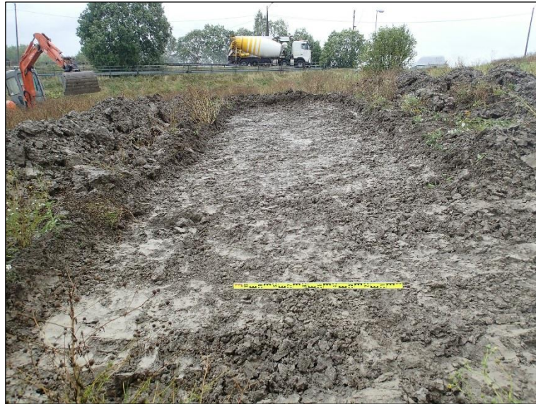
Tallbacka 1A, alue 2. Kaivausalue 86,4 m 2 . Kuva pohjoiseen.
