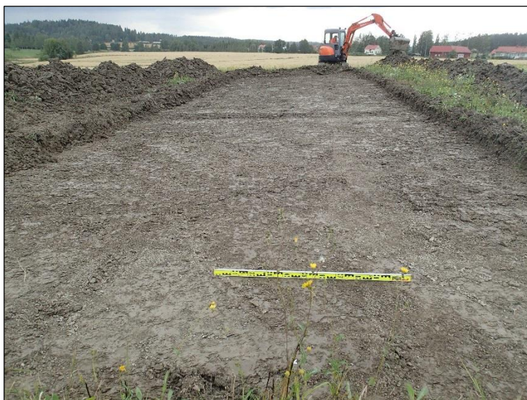
Tallbacka 1A, alue 1. Kaivausalue 203,7 m 2 . Kuva pohjoiseen.
